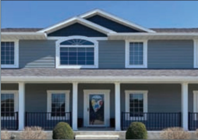
덱 / 사이딩 Deck / Siding
