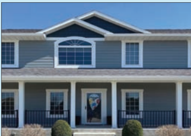
덱 / 사이딩 Deck / Siding
