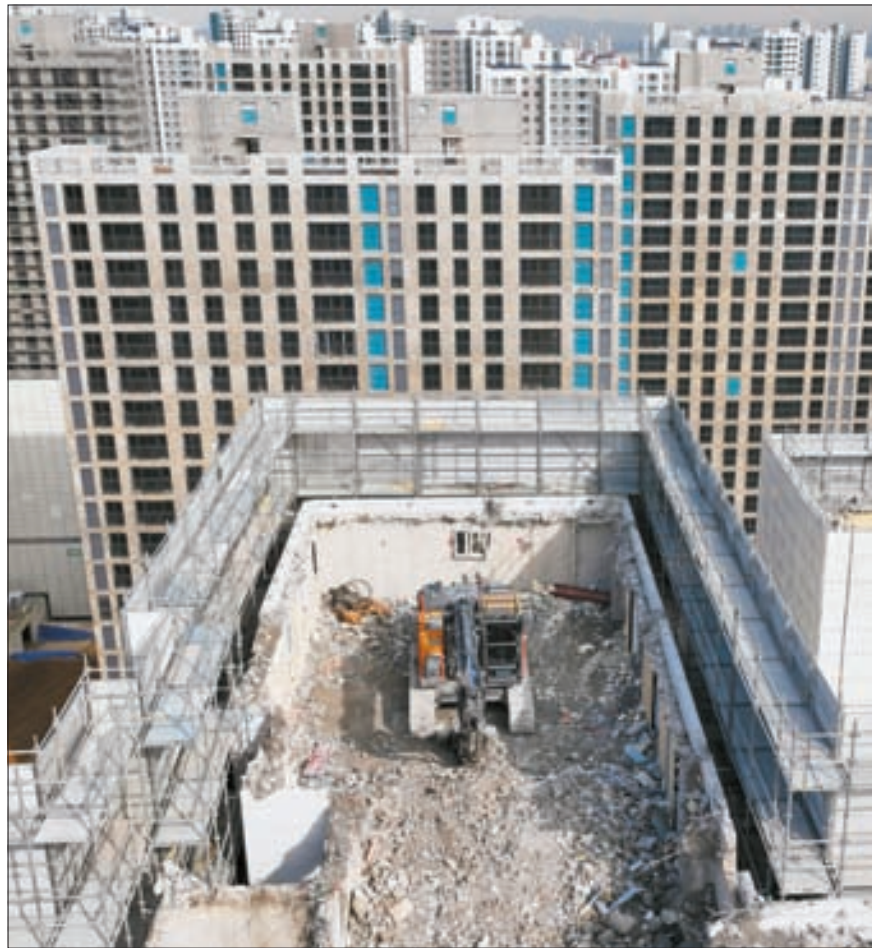
‘주차장 붕괴’ 검단아파트, 재시공 준비 신축 공사 중 지하주차장이 무너진 인천 검단신도시 아파트 건설 현장에서 19일 오후 굴착기가 재시공을 위해 골조 파쇄작업을 하고 있다. [연합뉴스]
