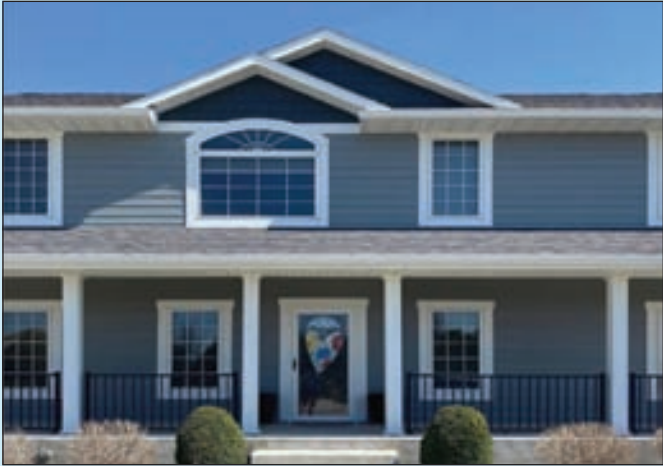
덱 / 사이딩 Deck / Siding
