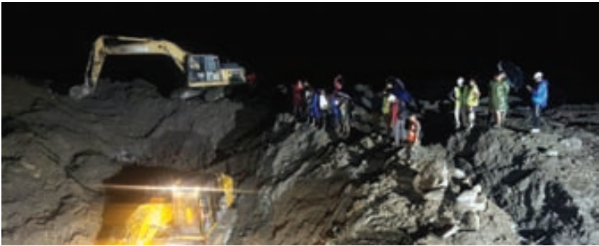
네팔 구조대, 수력발전소 터널 진입 공사 [로이터=연합뉴스]
