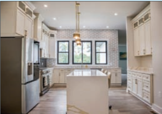
주방 리모델링 Cabinet, Sink, Faucets
