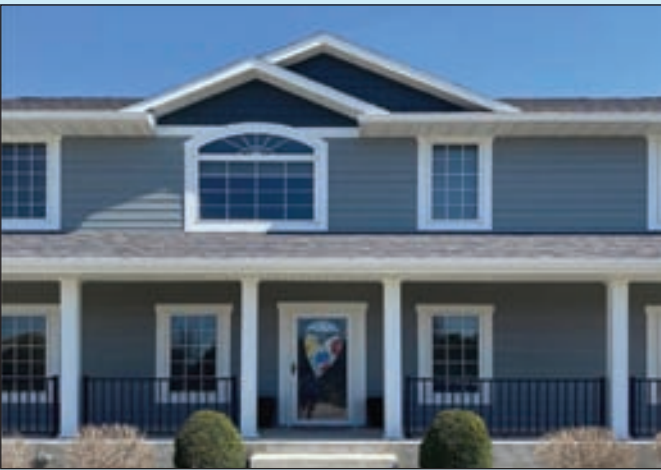
덱 / 사이딩 Deck / Siding
