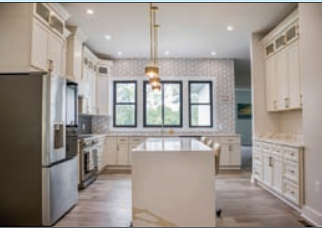
주방 리모델링 Cabinet, Sink, Faucets
