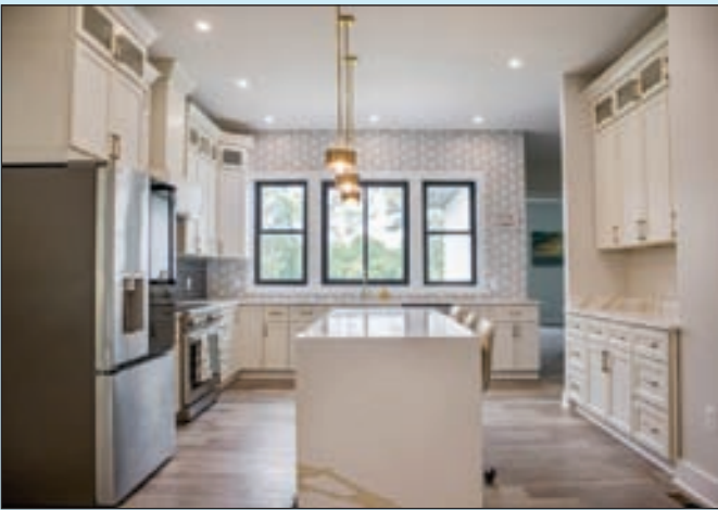
주방 리모델링 Cabinet, Sink, Faucets
