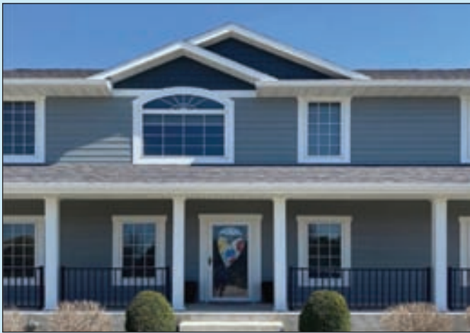
덱 / 사이딩 Deck / Siding
