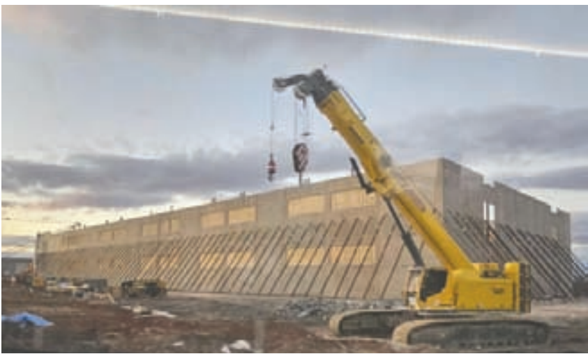
북버지니아 지역에 건설 중인 데이터 센터.
