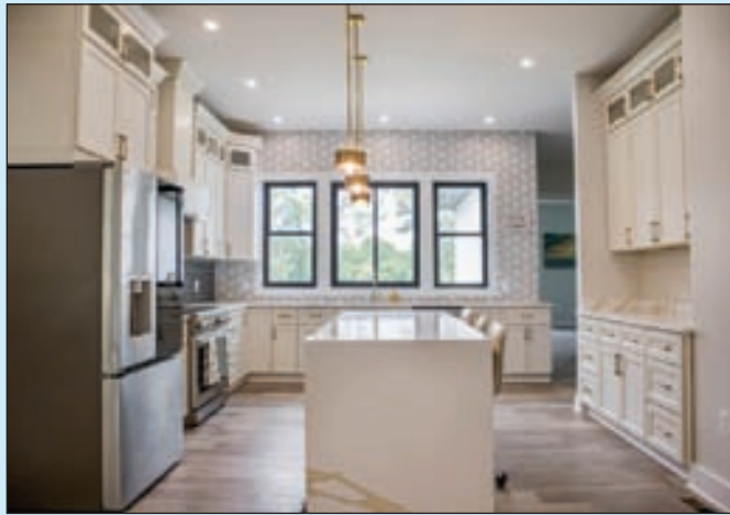
주방 리모델링 Cabinet, Sink, Faucets
