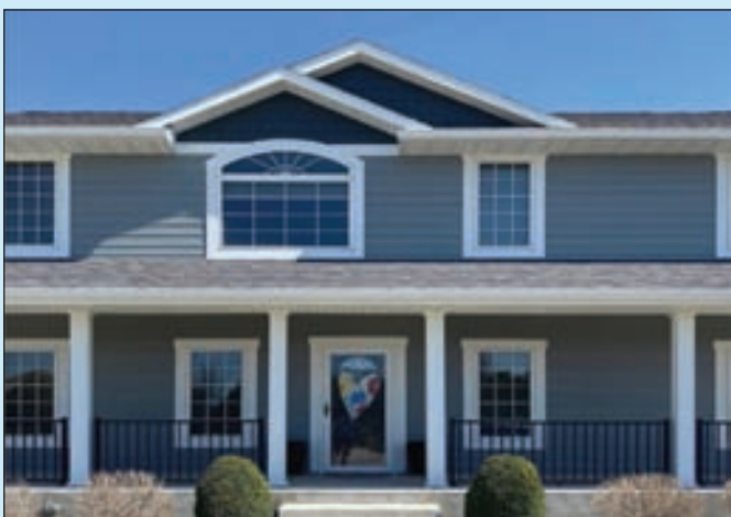
덱 / 사이딩 Deck / Siding
