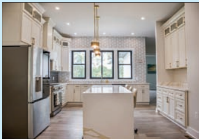
주방 리모델링 Cabinet, Sink, Faucets
