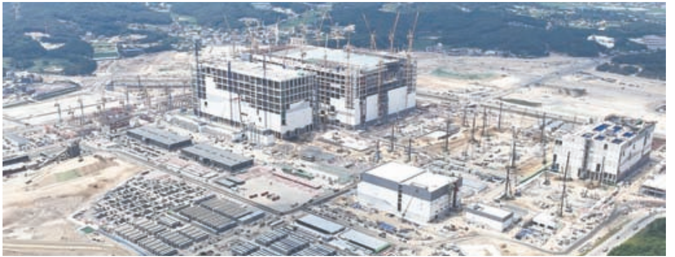
경기도 용인시 용인반도체클러스터 일반산업단지 공사현장의 모습.
