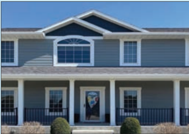
덱 / 사이딩 Deck / Siding
