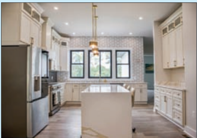
주방 리모델링 Cabinet, Sink, Faucets
