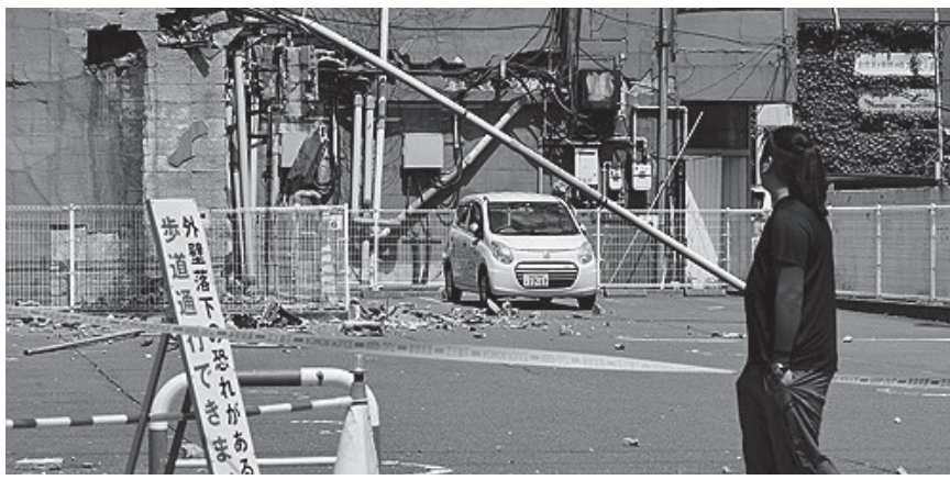
25일 지진으로 부서진 아오모리현 하치노헤시의 주차장 외벽
