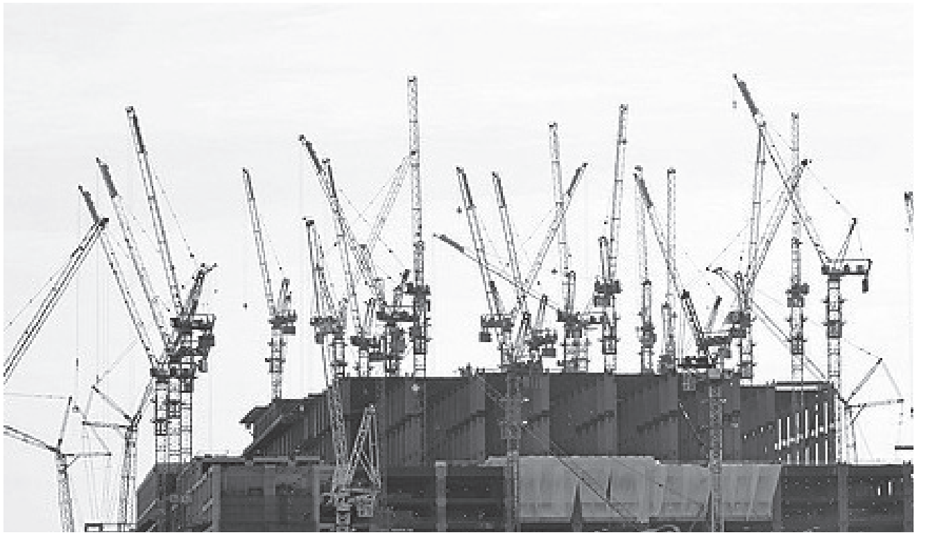
반도체클러스터 일반산업단지 공사현장.
