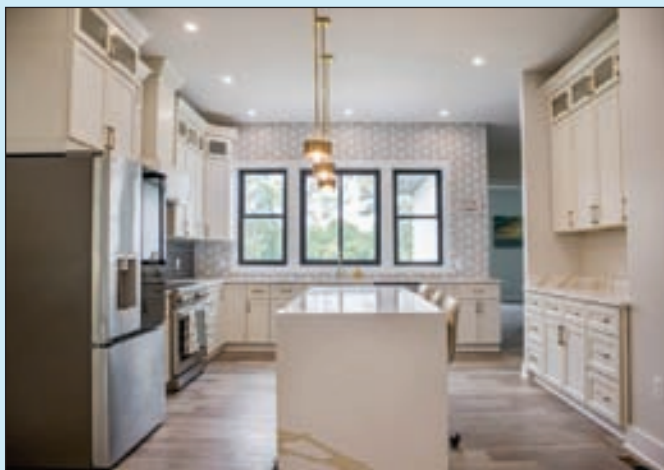
주방 리모델링 Cabinet, Sink, Faucets
