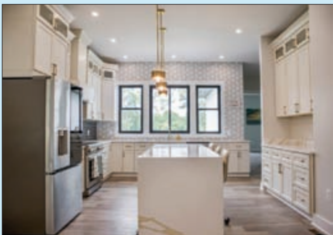
주방 리모델링 Cabinet, Sink, Faucets
