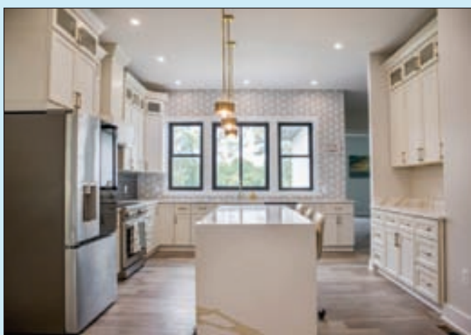
주방 리모델링 Cabinet, Sink, Faucets
