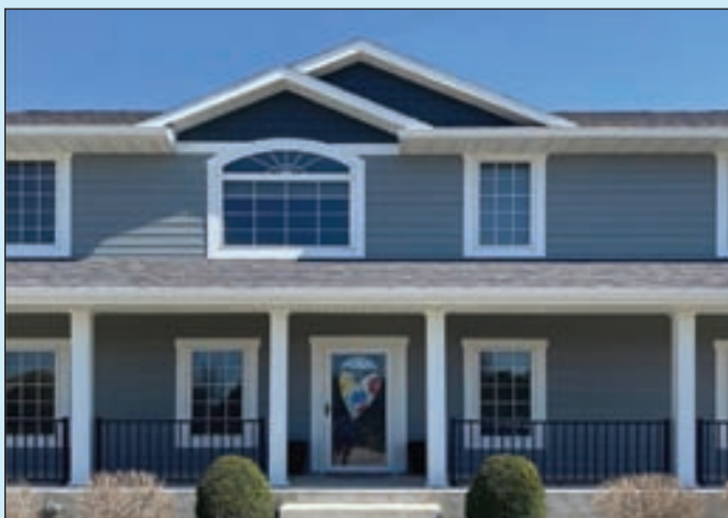
덱 / 사이딩 Deck / Siding
