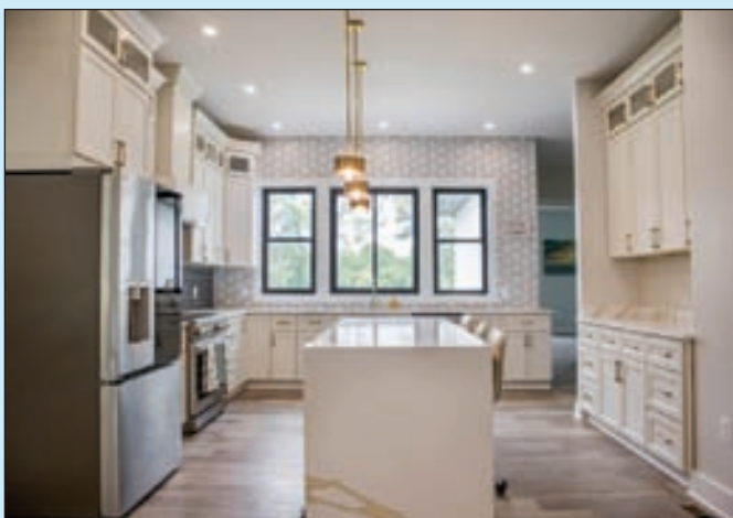
주방 리모델링 Cabinet, Sink, Faucets
