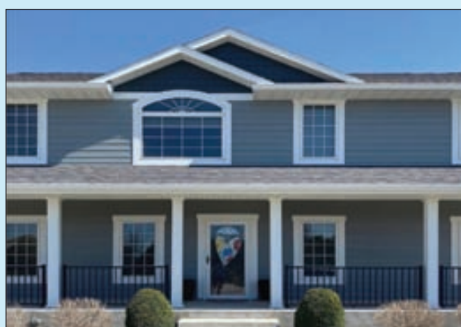
덱 / 사이딩 Deck / Siding
