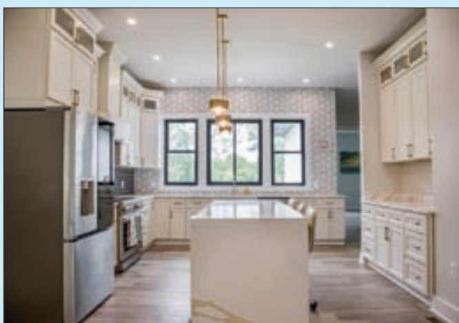
주방 리모델링 Cabinet, Sink, Faucets
