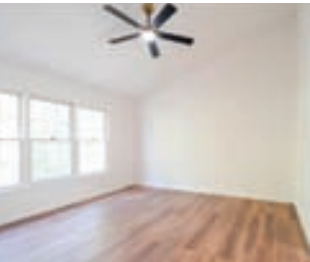
안방 카펫에서 마루시공, 씰링팬 설치
