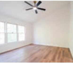
안방 카펫에서 마루시공, 씰링팬 설치
