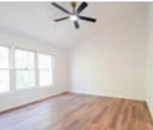
안방 카펫에서 마루시공, 씰링팬 설치
