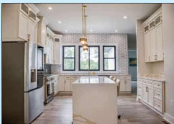
주방 리모델링 Cabinet, Sink, Faucets
