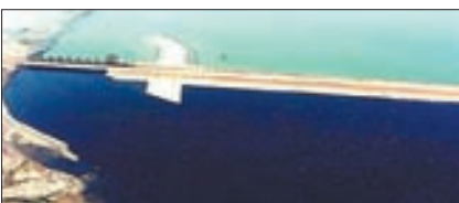
경기 안산 시화호조력발전소. 서해와 시화호의 낙차를 이용해 전기를 생산한다. 아래 사진은 1994년 방조제가 완공된 후 죽음의 호수로 변한 모습. 푸른 바다와 달리 시화호는 오페수 유입으로 검게 오염돼 있다. [사진 한국수자원공사]
