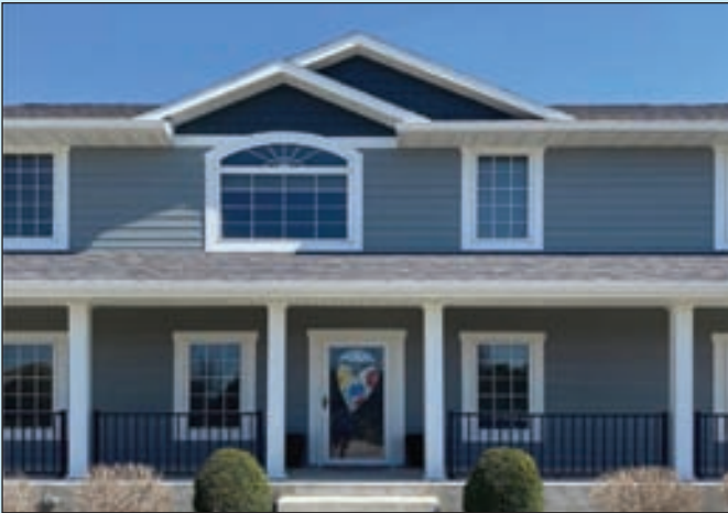
덱 / 사이딩 Deck / Siding
