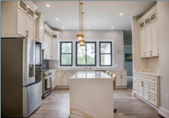
주방 리모델링 Cabinet, Sink, Faucets
