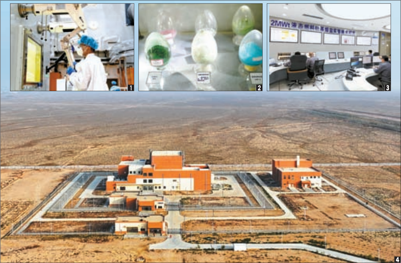
1 중국 연구원들이 실험용 토륨 용융염 원자로(TMSR)에서 샘플 추출 작업을 하고 있다. 2 TMSR의 주요 원료. 왼쪽부터 고순도 사불화 우라늄, 토륨 연료염, 저온 용해 질산염. 3 TMSR 가동 상태를 점검하는 제어실. 4 고비사막에 2020년 착공한 TMSR. [신화=연합뉴스]
