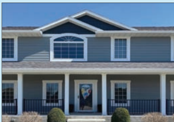
덱 / 사이딩 Deck / Siding
