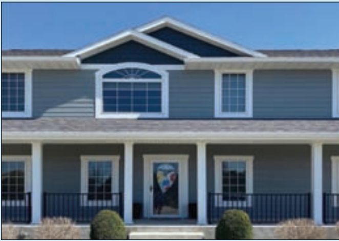
덱 / 사이딩 Deck / Siding
