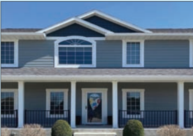
덱 / 사이딩 Deck / Siding
