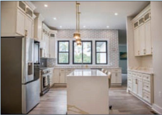
주방 리모델링 Cabinet, Sink, Faucets
