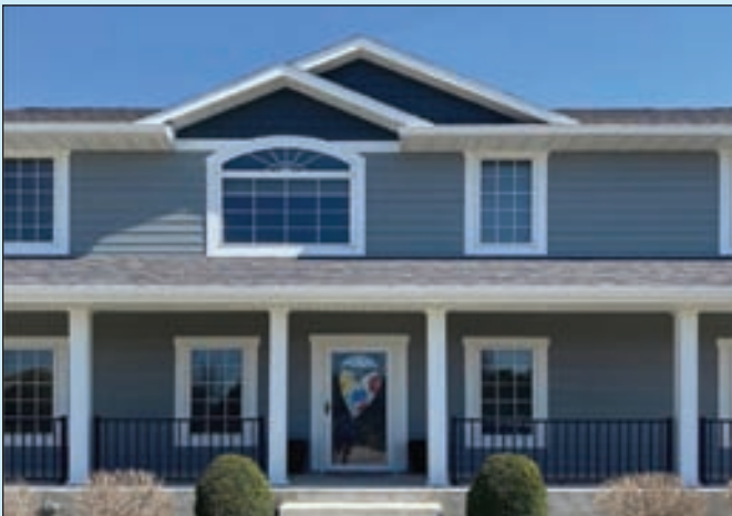
덱 / 사이딩 Deck / Siding
