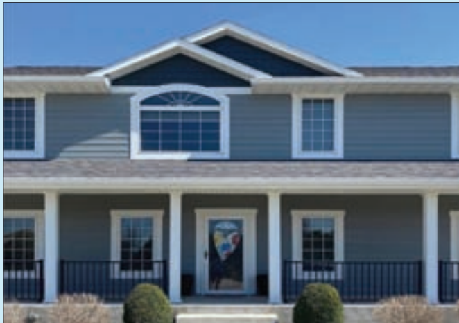
덱 / 사이딩 Deck / Siding
