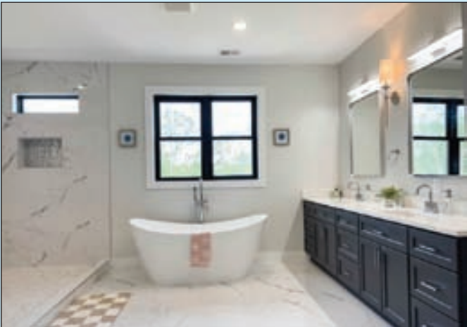
욕실 리모델링 Bathroom, Tile
