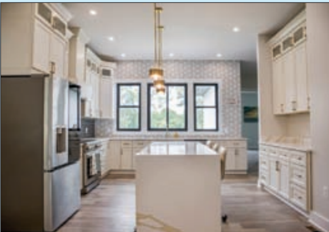
주방 리모델링 Cabinet, Sink, Faucets
