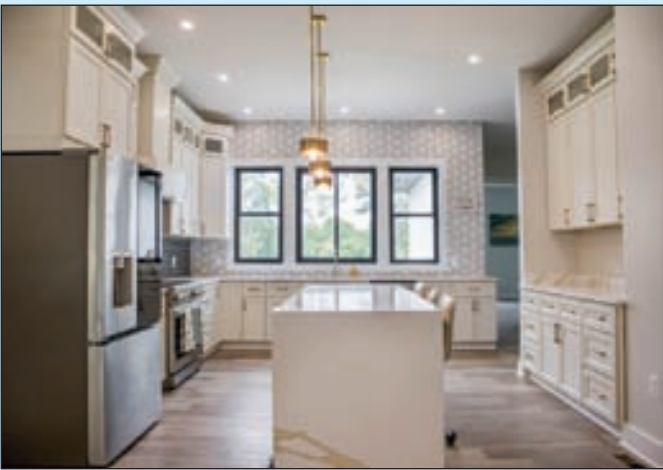
주방 리모델링 Cabinet, Sink, Faucets
