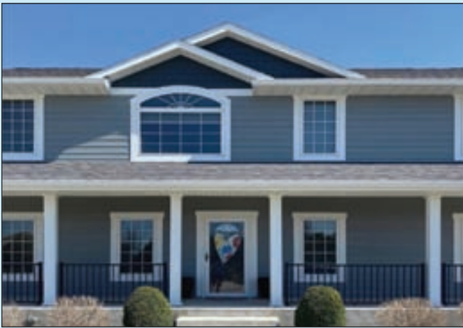
덱 / 사이딩 Deck / Siding
