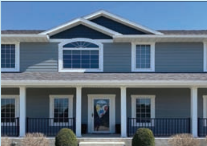
덱 / 사이딩 Deck / Siding
