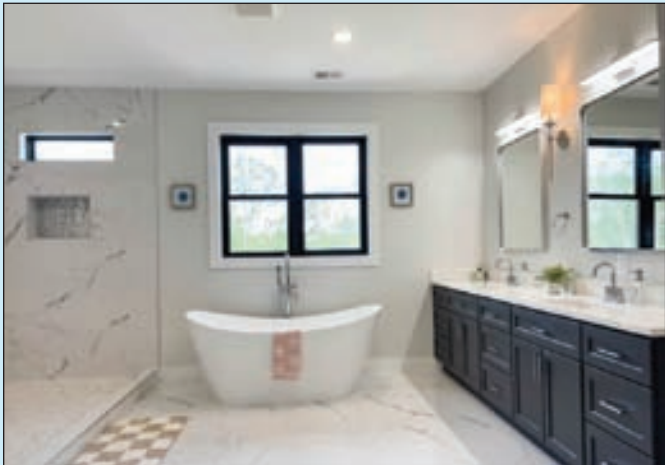
욕실 리모델링 Bathroom, Tile
