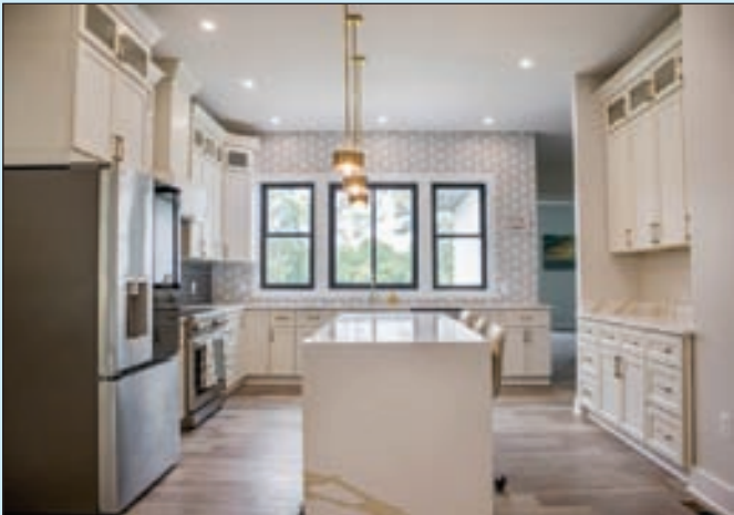
주방 리모델링 Cabinet, Sink, Faucets
