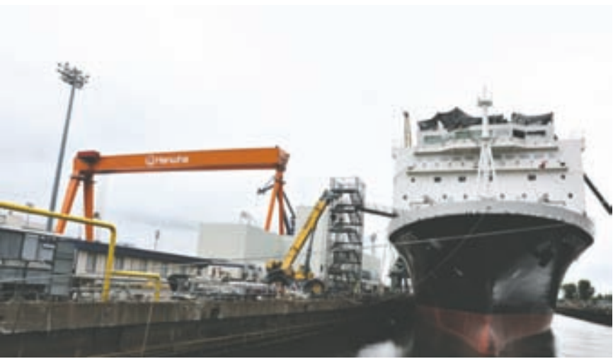
국가안보다목적선박(NSMV) 마무리 공정이 진행중인 한화필리십야드 5도크. [사진 한화오션]
