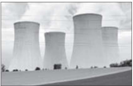
신규 원자력발전소 건설이 예정된 체코 두코바니에 원전 냉각기가 가동 중인 모습. 임성빈 기자
