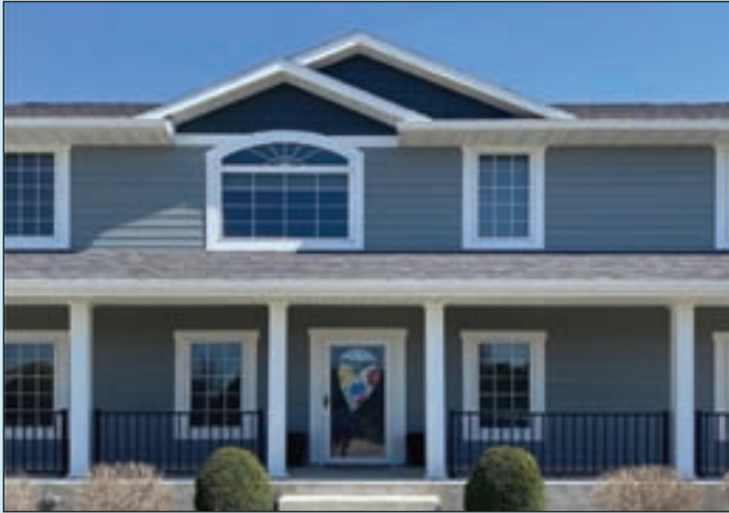
덱 / 사이딩 Deck / Siding
